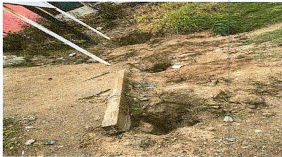
Foto 3: Sustitucion de tubos y malla.
