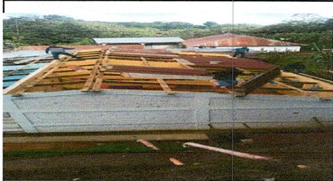
Foto1: Sustitucion de techo.
